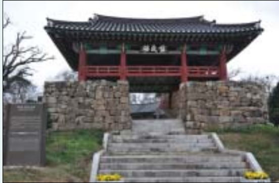
• 무장현 관아와 읍성 진무루(鎭茂樓) 전경
